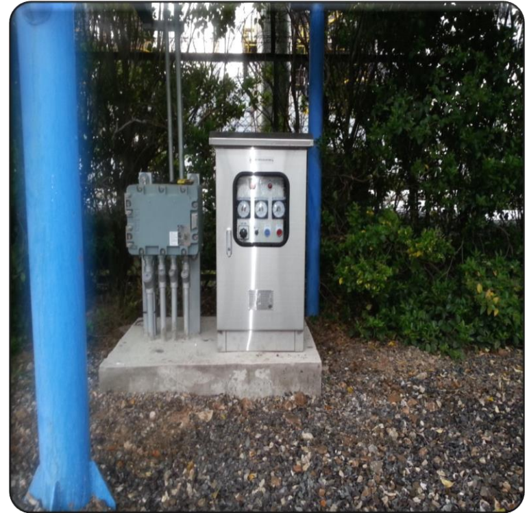
Rectifier Installation
