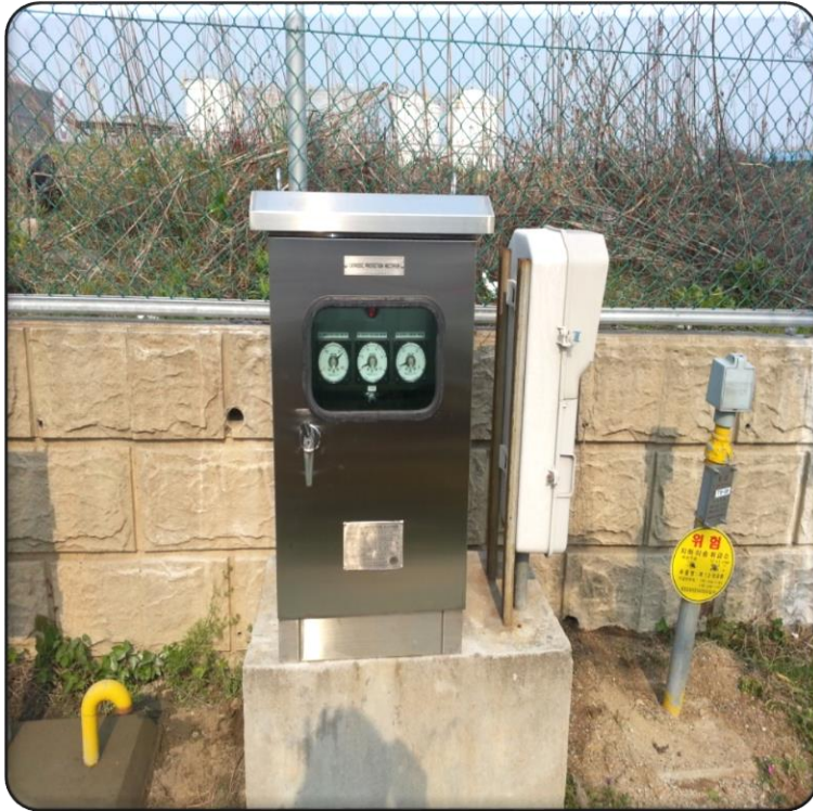
Rectifier Installation
